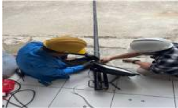
Gambar 8. Gambar Pemasangan Lampu
