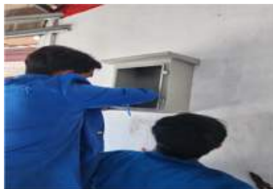
Gambar 10. Gambar Pemasangan Panel Pada Tembok Beton
