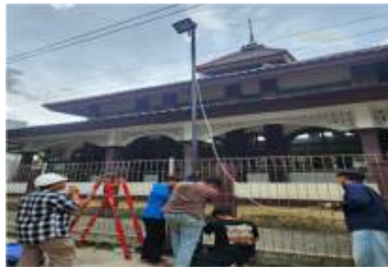
Gambar 9. Gambar Pemasangan Tiang Lampu
