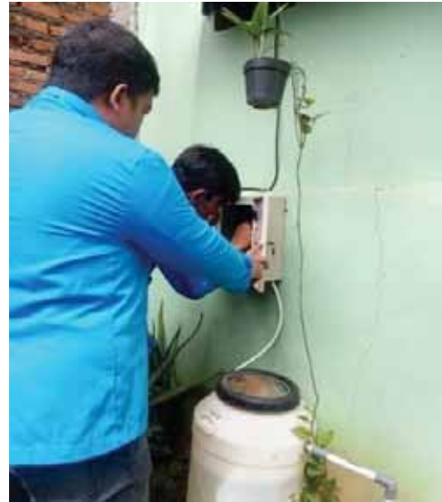
Gambar 4. Proses instalasi panel kontrol alat penyiram tanaman otomatis
