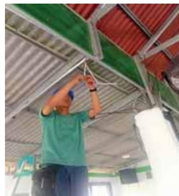
Gambar 4. Penyambungan kabel penerangan
