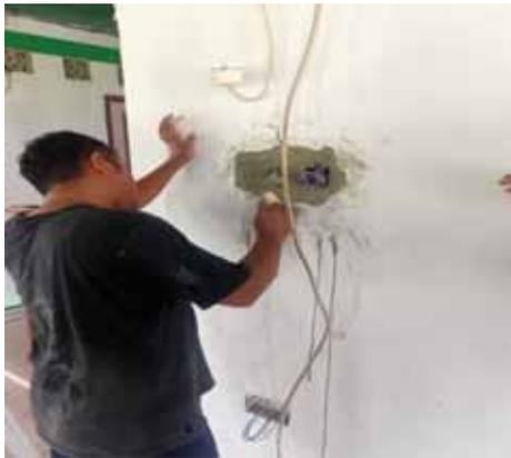
Gambar 5. Penyambungan kabel stop kontak dan penerangan Masjid
