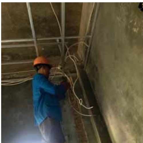
Gambar 1. Pemasangan lampu penerangan Musollah Nurul Fadillah
