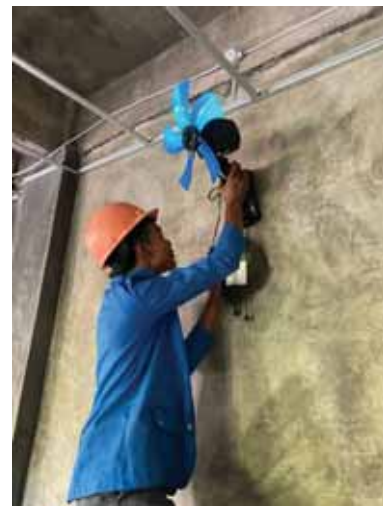
Gambar 3. Pemasangan sistem pendingin pada lantai 1
