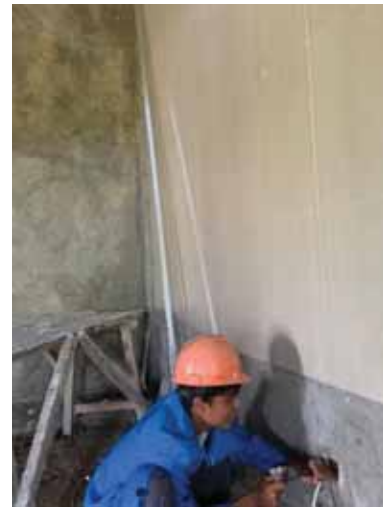
Gambar 2. Persiapan pemasangan stop kontak
