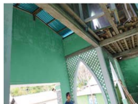
Gambar 6. Hasil dari pekerjaan perbaikan instalasi listrik
