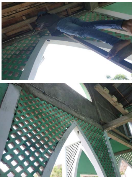
Gambar 7. Proses Pemasangan Lampu Teras dan Hasilnya
