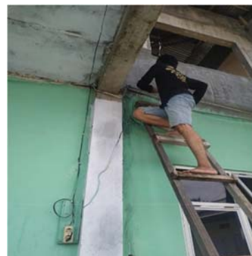
Gambar 5. Pemasangan instalasi dalam rumah tahfiz quran
