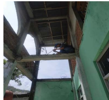
Gambar 4. Pemasangan instalasi listrik bagian timur rumah tahfiz quran
