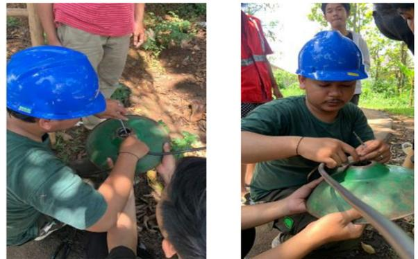
Gambar 1. Proses pemasangan pengkabelan lampu PJU
