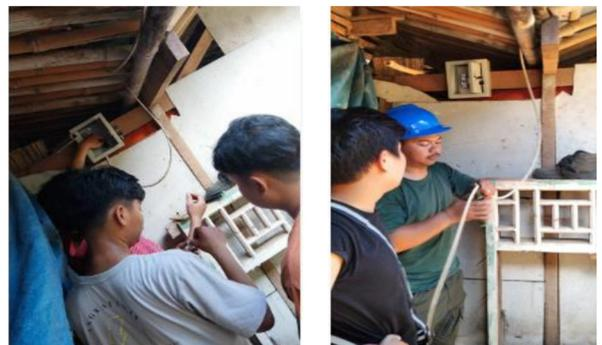
Gambar 3. Proses perakitan perapihan kabel panel listrik
