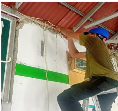
Gambar 6. Penyambungan kabel penerangan Masjid Babusalam
