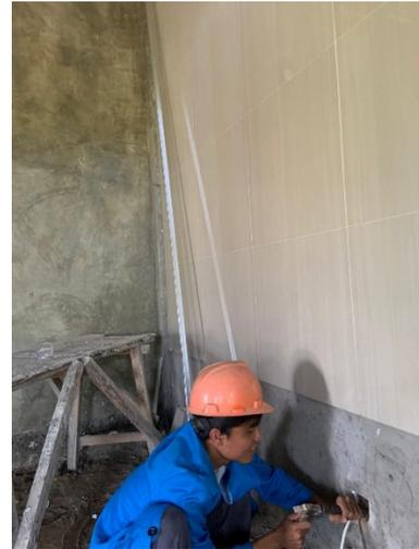
Gambar 2. Persiapan pemasangan stop kontak
