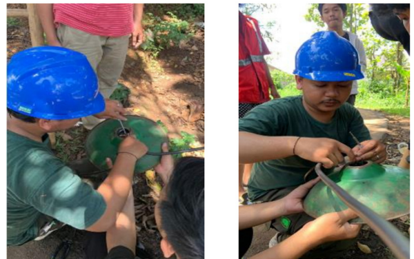
Gambar 1. Proses pemasangan pengkabelan lampu PJU
