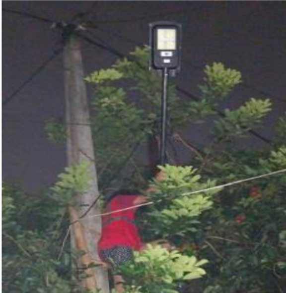
Gambar 4 Hasil akhir pengerjaan pemasangan penerangan panel yang telah terpasang
