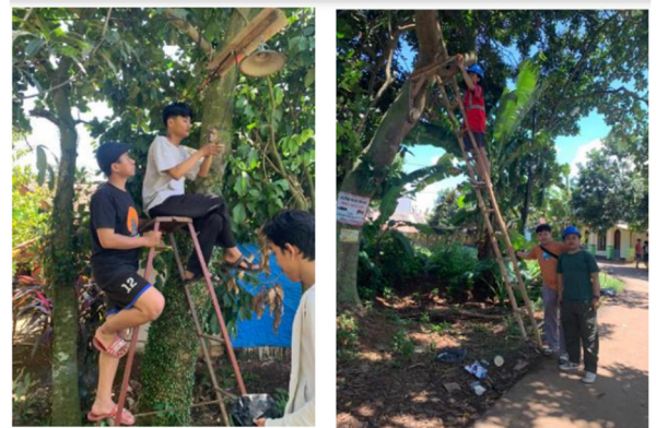
Gambar 2. Proses perakitan perapihan kabel panel listrik
