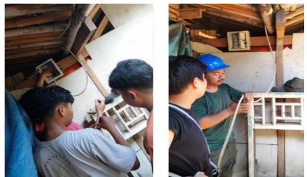
Gambar 3. Proses perakitan perapihan kabel panel listrik
