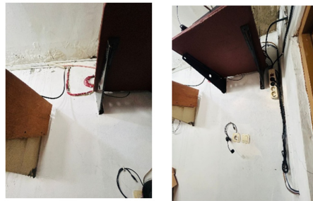
Gambar 3. Perapian jalur instalasi dan penataan perangkat sound system
