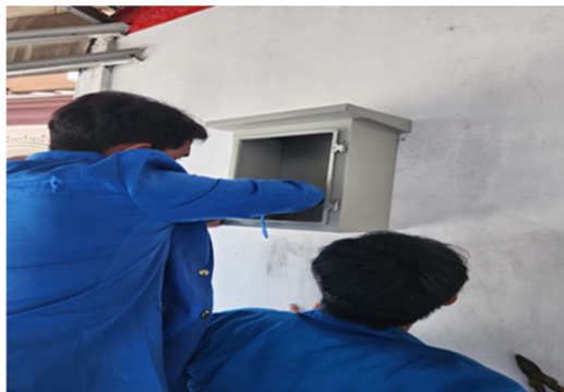
Gambar 10. Gambar Pemasangan Panel Pada Tembok Beton
