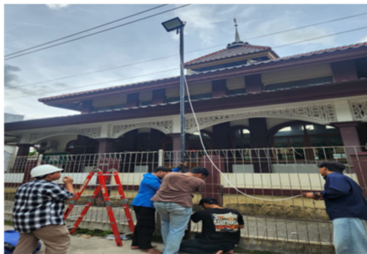
Gambar 9. Gambar Pemasangan Tiang Lampu
