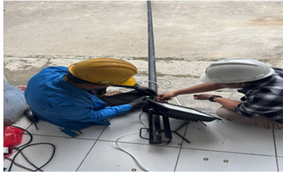
Gambar 8. Gambar Pemasangan Lampu
