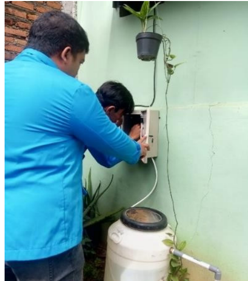
Gambar 4. Proses instalasi panel kontrol alat penyiram tanaman otomatis
