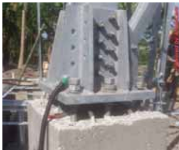
Gambar 13. Penyambungan Kabel BC Spiral Ke Kaki Menara
