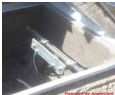
Gambar 14. Penyambungan Kabel BC Spiral Ke Bak Kontrol
