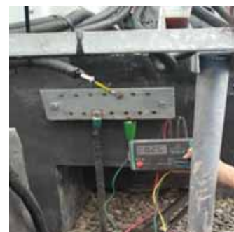
Gambar 17. Pengukuran Tahanan Pentanahan pada kali-kaki Menara BTS
