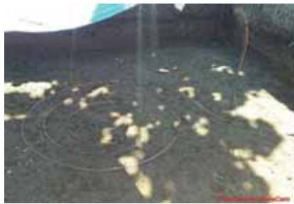
Gambar 12. Pemasangan Kabel BC Spiral
