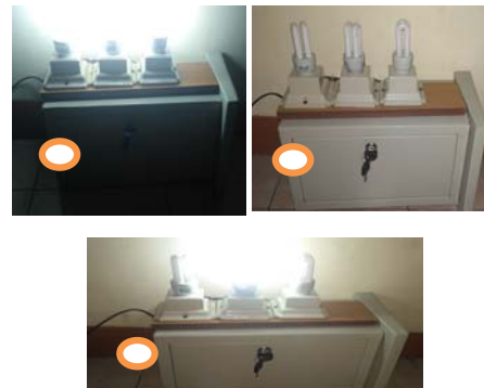
Gambar 17. Pengujian tombol Web server dan prototype Kontrol Lampu Gedung
