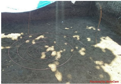
Gambar 12. Pemasangan Kabel BC Spiral
