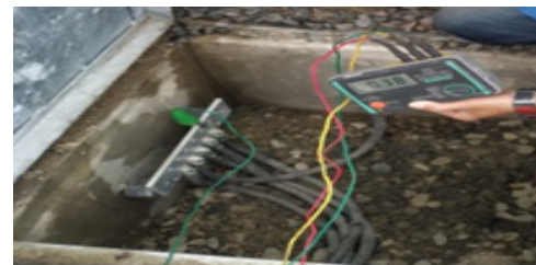
Gambar 16. Pengukuran Tahanan Pentanahan pada bak kontrol Menara BTS
