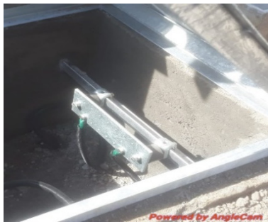
Gambar 14. Penyambungan Kabel BC Spiral Ke Bak Kontrol
