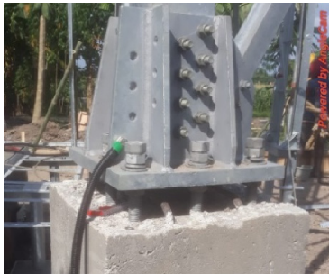
Gambar 13. Penyambungan Kabel BC Spiral Ke Kaki Menara
