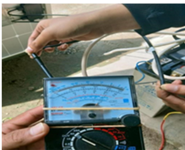
Gambar 11. Pengukuran Tegangan dan Arus Pada Panel Surya
